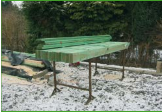
Das Ablegen von Holzbalken auf Bänken erleichtert das Aufnehmen oder Sägen
