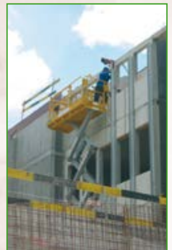
Dank Lastaufzug muss das Material nicht übers Gerüst geschafft werden
