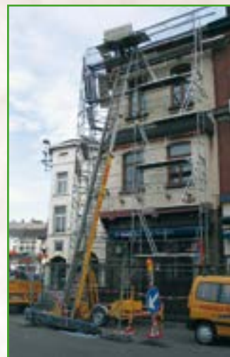
Dank Lastaufzug muss das Material nicht übers Gerüst geschafft werden
