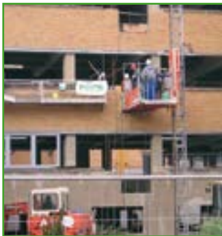
Mit dem Gondelsystem lassen sich Material und Personen nach oben befördern
