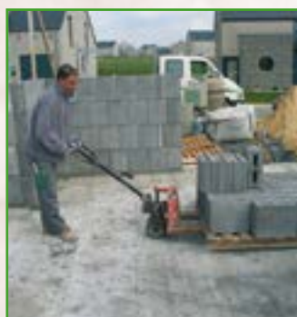
Handpalettenwagen zur Beförderung von Blocksteinen
