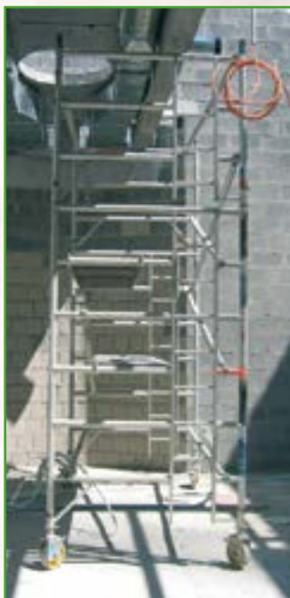
Ein Gerüst auf Rollen lässt sich leicht verschieben
