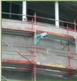
Seilwinde an einem Gerüst oder Ausleger
