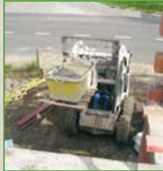
Abstellen des Mörtelkübels auf dem Gerüst mit einem Gabelstapler
