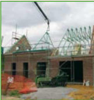
Transport der vorgefertigten Dachstuhlelemente
