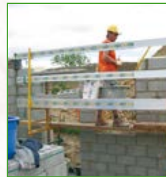
Zweistufiges höhenverstellbares Gerüst mit Kurbel
