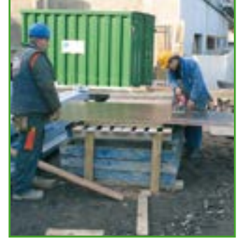
Verwendung einer erhöhten Auflage für den Zuschnitt von Schalbrettern statt Zuschneiden am Boden
