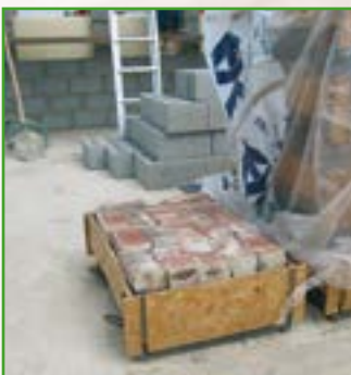
Backsteine in Behältern oder Containern, die mit einem Kran oder Gabelstapler transportiert werden können
