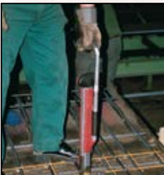
Drahtbindeapparat zum Verbinden von Bewehrungsstahl in aufrechter Haltung
