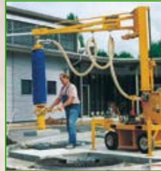
Ausleger mit Vakuumgreifer zum Heben von Betonplatten
