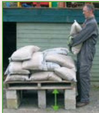
Ablagen mit fester Höhe zum Abstellen von Sand- und Zementsäcken auf geeigneter Höhe
