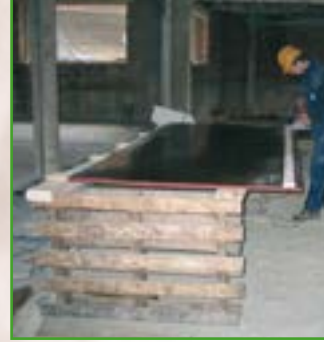
Verwendung einer erhöhten Auflage für den Zuschnitt von Schalbrettern statt Zuschneiden am Boden
