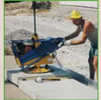
Ausleger mit Vakuumgreifer zum Heben von Betonplatten
