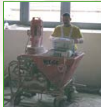
Mischer und Pumpe zum Putzspritzen
