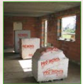
Lagerung von Paletten mit Blocksteinen und Gipsplatten direkt vor der einzuziehenden Wand
