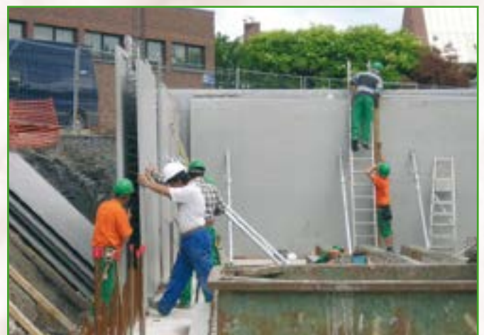
Vorgefertigte Wandelemente ersetzen Blocksteine
