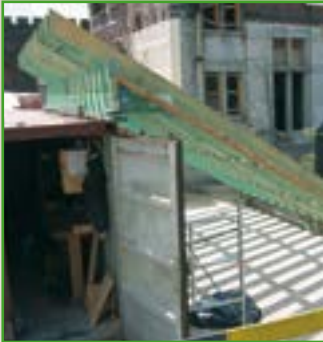
In der Halle vorgefertigter Dachstuhl
