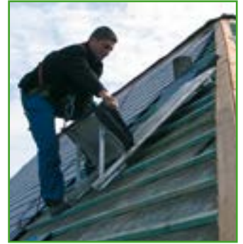
Kleiner Aufzug für Dachsteine und Dachziegel auf dem Steildach
