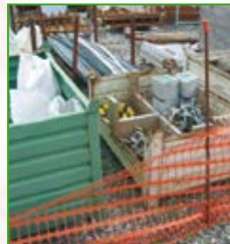
Metallcontainer zur Aufbewahrung von Zubehör, mit dem Kran transportierbar
