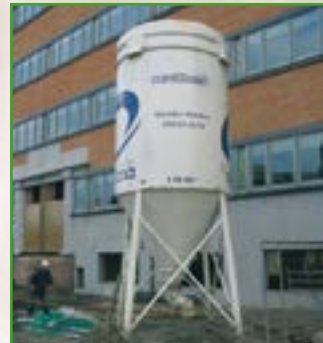
Silomischanlage statt klassischer Mischmaschine
