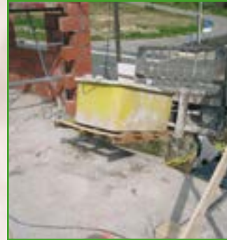
Abstellen des Mörtelkübels auf dem Gerüst mit einem Gabelstapler
