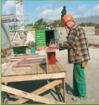
„Tische“ für die Arbeitsvorbereitung, das Zusägen und Messen
