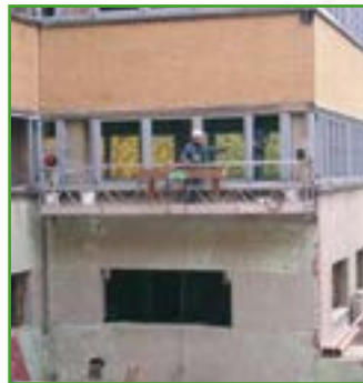
Mit dem Gondelsystem lassen sich Material und Personen nach oben befördern
