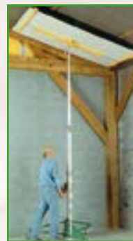
Gipsplattenstütze für die An- bringung unter der Decke
