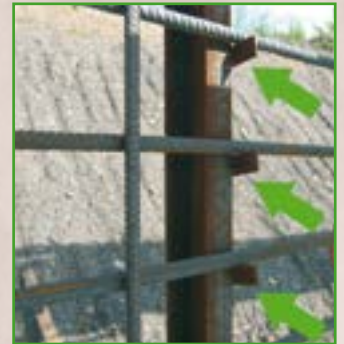
Waagrechte Auflagen auf den Trägern stützen die Betonstäbe
