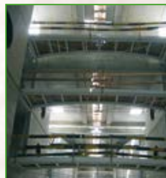
Frühzeitig verlegte Laufplanken zwischen Gebäuden
