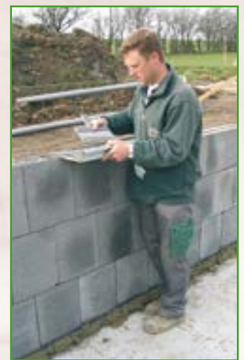
Auftragen des Klebemörtels auf Blähtonsteinen mit der Spachtel
