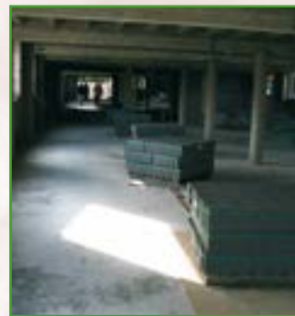
Lagerung von Paletten mit Blocksteinen und Gipsplatten direkt vor der einzuziehenden Wand
