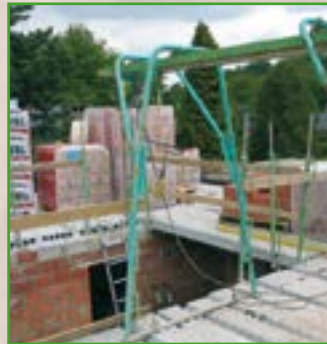
Seilwinde an einem Gerüst oder Ausleger
