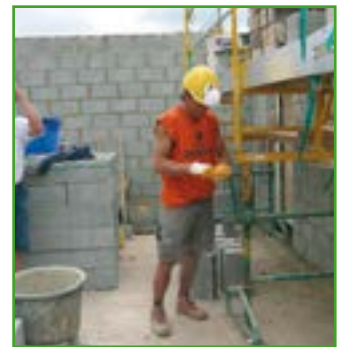
Zweistufiges höhenverstellbares Gerüst mit Kurbel
