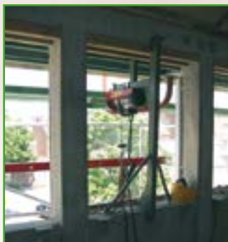
Seilwinde zum Einsetzen der Fensterrahmen und der Wandverkleidung
