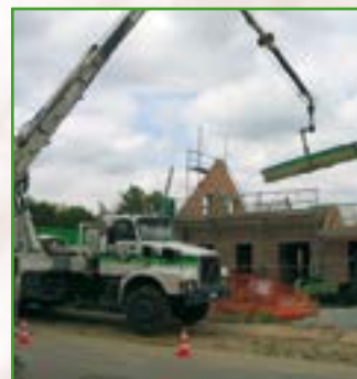
Einsatz des Krans zum Heben von Dachstuhlelementen und Baustoffen
