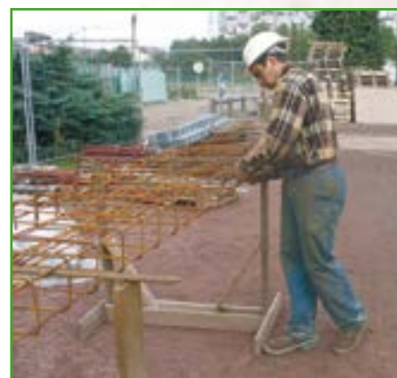
Arbeitshöhe zum Biegen von Metallstäben Arbeitshöhe zum Verbinden von Metallstäben Tisch für leichte Arbeit im Baucontainer
