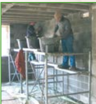
Zweistufiges Gerüst
