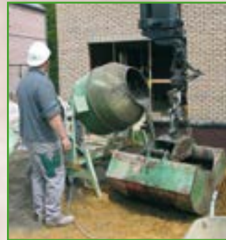
Kranschaufel schafft Gemisch in obere Stockwerke
