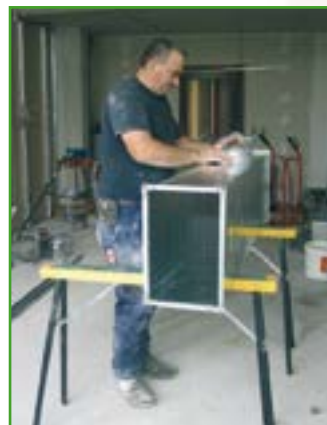
Bänke ersparen das Bücken bei der Vorbereitung der Rohre
