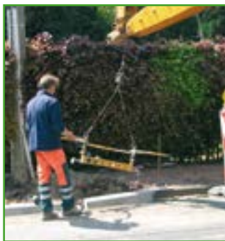
Bordsteingreifer an Baustell- Maschine mit Vakuumgreifer lenfahrzeug zum Befördern zum Verlegen vieler Pflaster- schwerer Lasten steine auf einmal
