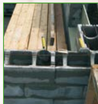
Hohlblock-Fundamentsteine werden mit Beton vollgepumpt
